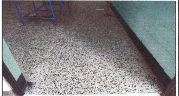
Foto 2: Sustitución de piso por piso granito.
